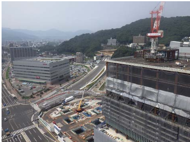
二葉の里地区(広島駅北口周辺)
