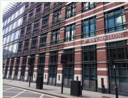
インサイト本社が入居するBNYメロンセンタービル
