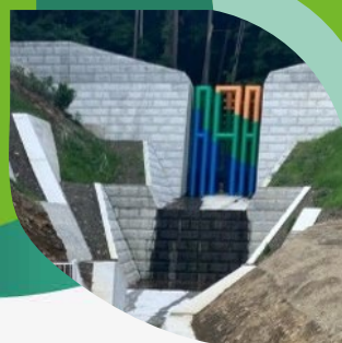
砂防関係施設整備
